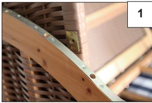
Zunächst halten Sie den Oberkorb bitte so zum Unterkorb, dass sich die bereits vormontierte Schraubplatte am Oberkorb in der Mitte von zwei Löchern auf der Schiene am Unterkorb befindet.
