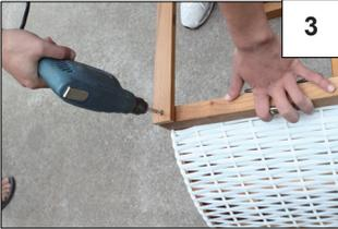
3 Verschrauben Sie nun Frontseite und Unterkasten mit den flachen Latten (3) – verwenden Sie je 2 Schrauben (C).
