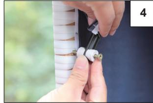
**4** Zur Befestigung der Markise nutzen Sie bitte Schraube (A) inkl. der Kunststoffklemmen (D). Je eine Klemme um die Markisenführung stecken und die Schraube an der markierten Stelle von innen in das Seitenteil schrauben.
