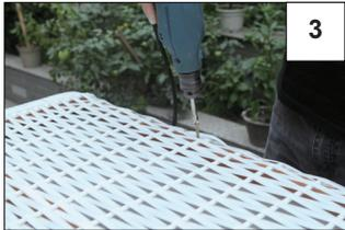
**3** Mit Hilfe von 2 Schrauben (A) wird die Dachplatte zusätzlich an der Rückwand fixiert. Die entsprechenden Stellen sind durch Pfeile markiert.
