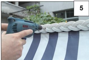
**5** Optional können Sie die Zierleiste am Oberkorb anbringen. Fügen Sie hierzu die Teile der Zierleiste (10) zusammen und schrauben Sie mit Hilfe der beigelegten Schrauben an den Oberkorb (oberhalb der Markise).
