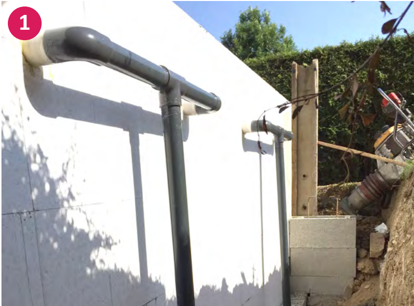
▲ Verrohrung von 4-Düsen
