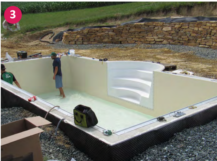
▲ Einhängen des Foliensacks und Anflanschen der Einbauteile
