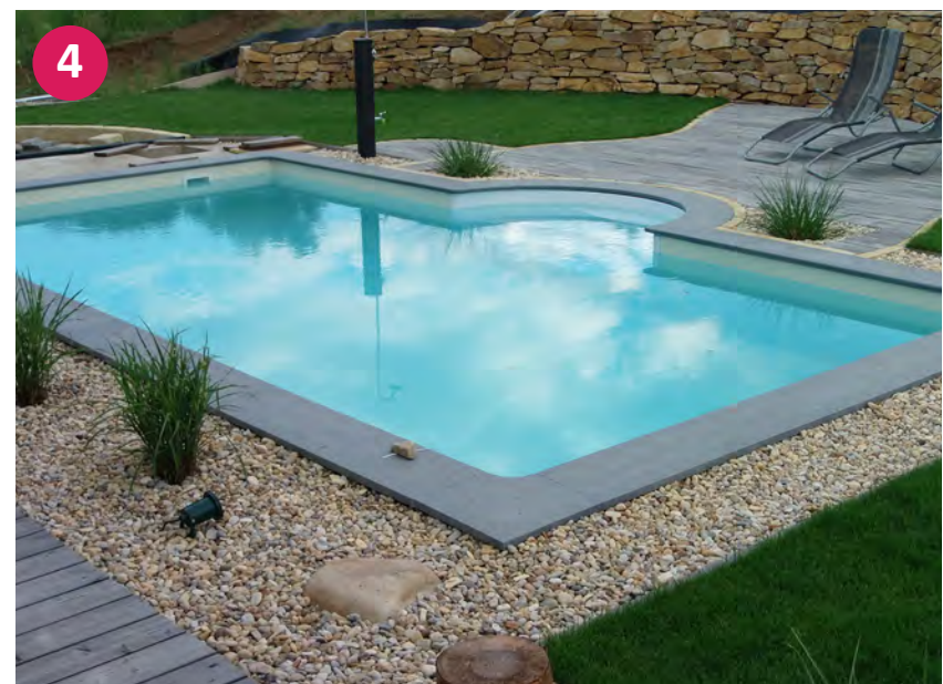
▲ Fertiges Styroporsteinbecken mit Römertreppe
