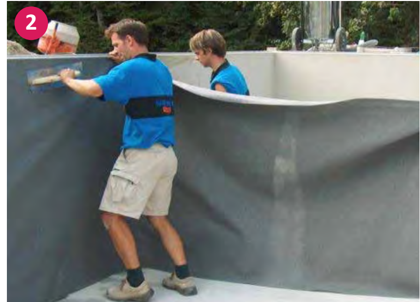
▲ Punktuelle Befestigung der Vliestrennlage mittels Styroporkleber
