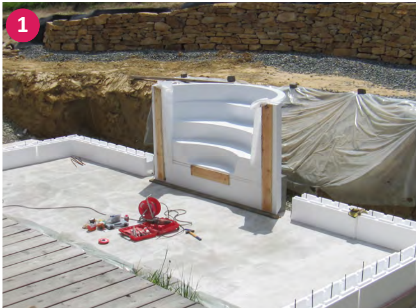
▲ Römertreppe mit erster Ansatzreihe Styroporsteine
