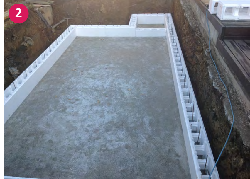
▲ Ansätzen der ersten Reihe Styropor Steine
