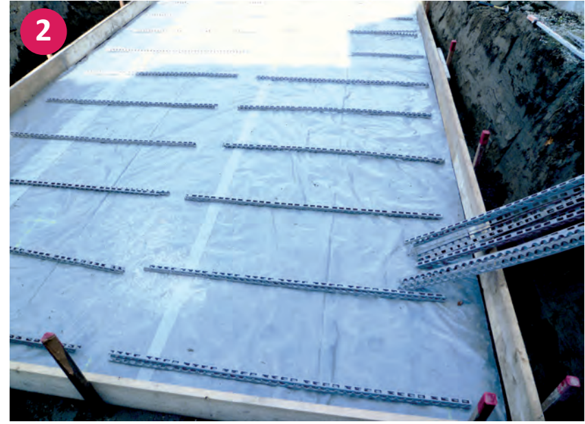
▲ Abschallung der Bodenplatte
