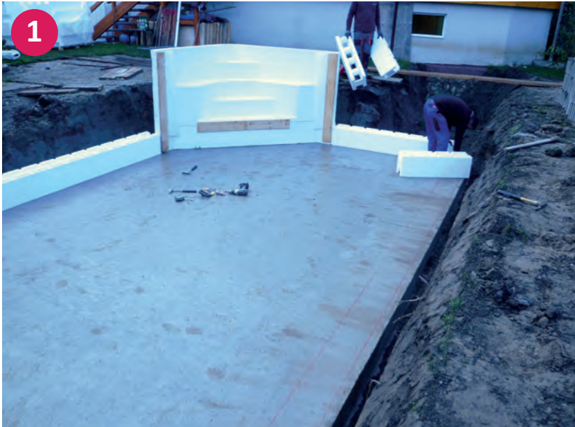
▲ Ecktreppe mit erster Ansatzreihe Styroporsteine
