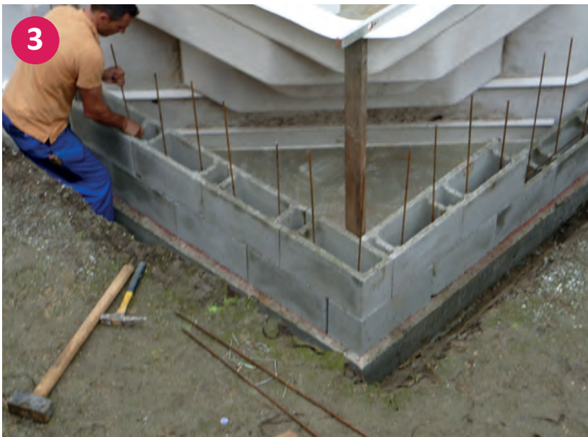
▲ Untermauerung der Ecktreppe
