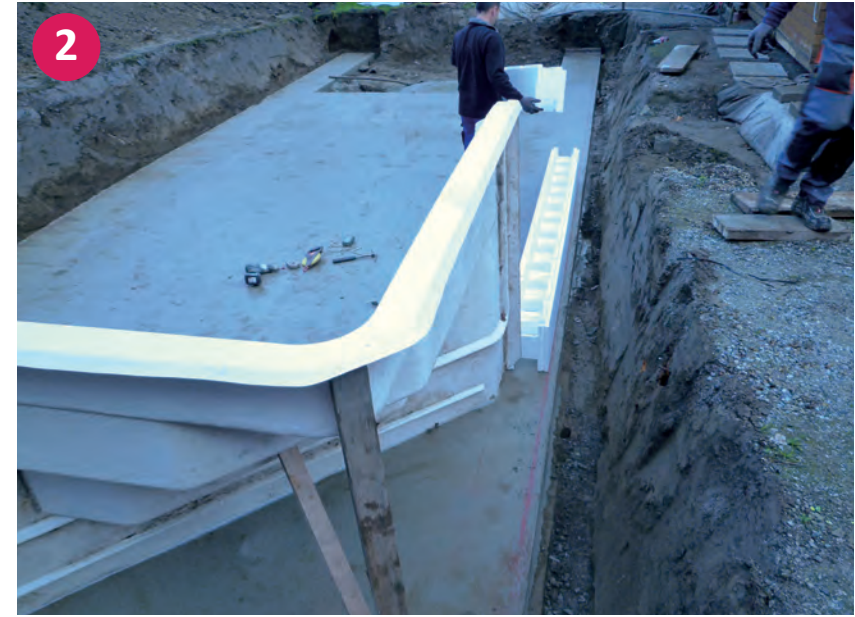
▲ Abstützen sowie senkrecht und waagerechte Einrichtung der Ecktreppe
