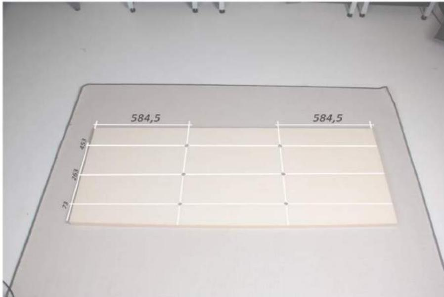
Legen Sie die Arbeitsplatte mit der Arbeitsseite auf eine vor Kratzern schützende Unterlage. Markieren Sie auf der Arbeitsplatte die gekennzeichneten Positionen.
